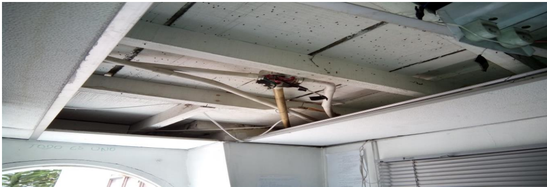
Foto No. 1 Problemas Eléctricos.
