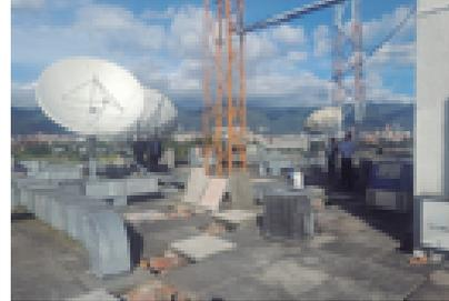
Placa con empozamiento de agua, lama y basura –La terraza no cuenta con la pendiente correspondiente para su desagüe; el agua no corre libremente ya que los ladrillos que soportan las plaquetas realizan obstrucción.
